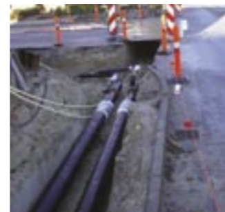
Foto: Brønderslev Kommune
