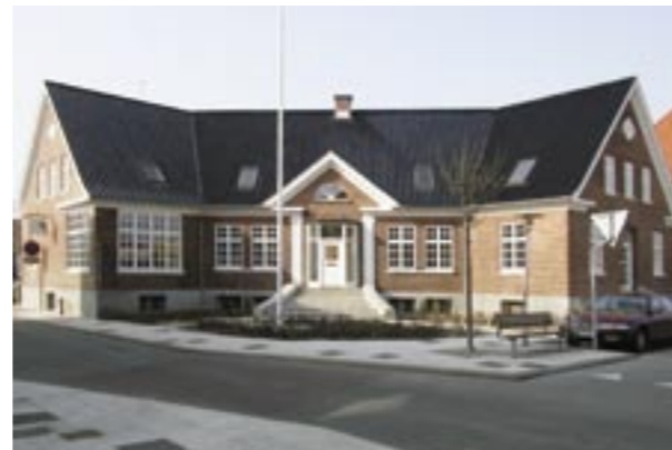
Foto: Brønderslev Kommune.
